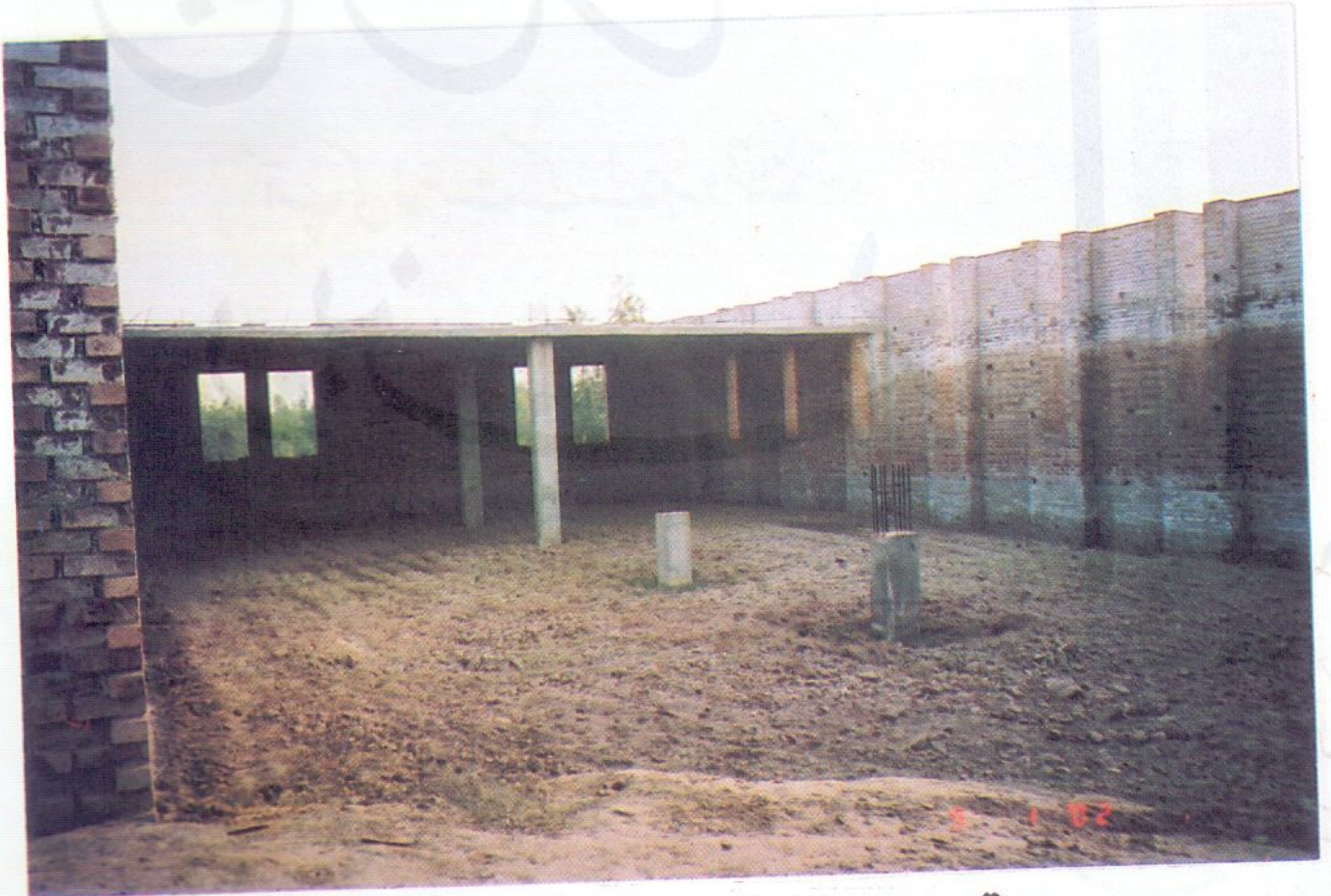
رائیونڈ روڈ زیر تعمیر مسجد حامد کے ہال کی شمالی اور جنوبی گیلری کا لینئر جو مکمل ہو چکا ہے
