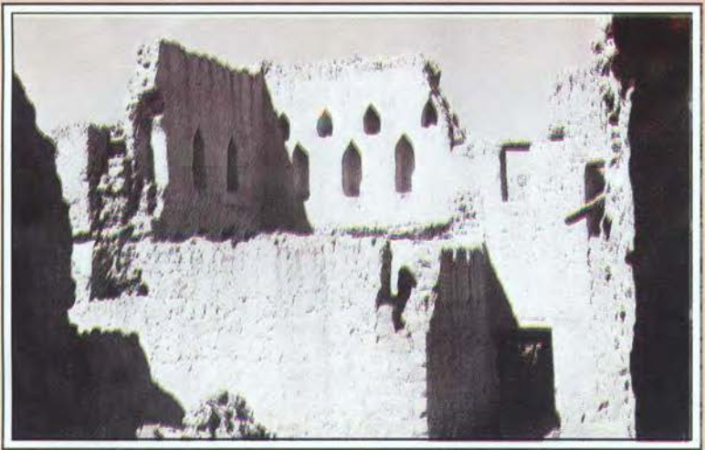
قدیم اسلامی فن تعمیر کا ایک نمونہ جو خیبر میں ”قصر مہب“ کے نیچے فتح خیبر کے بہت بعد کبھی بنایا گیا تھا۔
